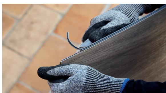
Postavite ploču s izrezanim stranama uza zidove. Odstojnicima ispunite konturu zida tako da se ploče ne pomiču, da su ravne i 100 % pravilno ugrađene i međusobno učvršćene.
