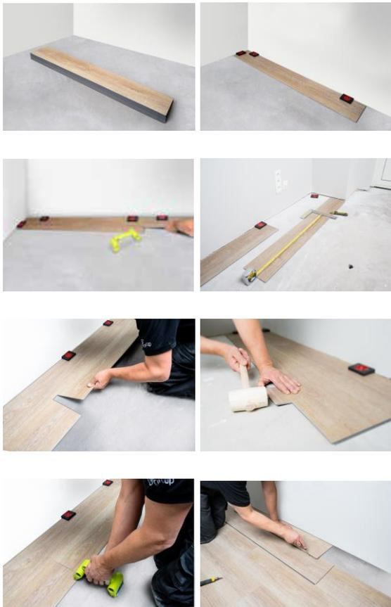
11. A continuación, instale la segunda lana deslizándola la ranura inferior, en un ángulo de 25° , en la lengüeta de la fila anterior. Apoye la esquina izquierda del extremo delantero en la lana anterior y deje caer el lado corto del perfil sobre el extremo de esta. Empuje hacia abajo y presione para que encaje en su posición con un rodillo de mano. Repita la operación hasta que llegue al final de la fila. No emplee el martillo para las uniones de los extremos.
