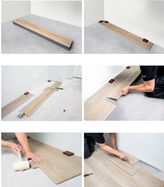
11. En règle générale, il est nécessaire d'ajuster la largeur la dernière ligne de lames ou dalles pour terminer l'installation. Procédez comme suit : placez une lame ou dalle en superposition de la ligne précédente, rainure vers le mur ; placez une autre lame ou dalle à l'envers en contact avec le mur (en tenant compte de la dilatation à respecter) et marquez la lame ou dalle à couper. Coupez la lame ou dalle à la bonne taille et ajustez la dernière ligne.
