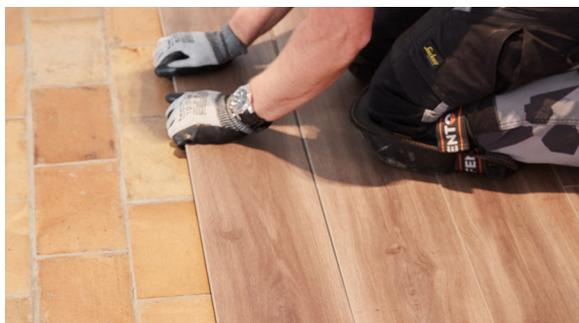
Les chambranles de portes, les tuyaux de chauffages et autres "points durs" doivent également être ajustés afin de respecter l'espace de dilatation nécessaire..
