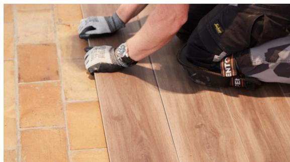
En règle générale, il est nécessaire d'ajuster la largeur la dernière ligne de lames ou dalles pour terminer l'installation. Procédez comme suit: placez une lame ou dalle en superposition de la ligne précédente, placez une autre lame ou dalle en direction du mur (en tenant compte de la dilatation à respecter) et marquez la lame ou dalle à couper. Coupez la lame ou dalle à la bonne taille et ajustez la dernière rangée.
