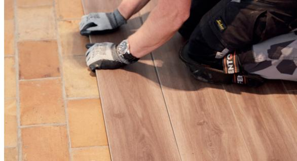
Para instalar la última fila de lamas, normalmente tendrá que cortarlas. Para ello, siga estos pasos: coloque una lama sobre la fila anterior con la ranura orientada hacia la pared. Coloque otra lama boca abajo contra la pared y marque la lama de debajo. Corte la lama siguiendo la marca e instale la última fila.
